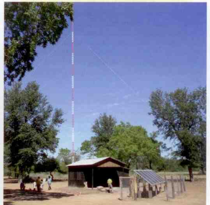
Fuente: Superintendencia de Energías Renovables Itaipu Binacional - 2013
